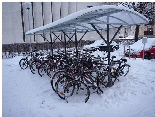
Katoksellinen pyöräparkki jväskyläläisen taloyhtiön pihassa. Kuten kuvasta näkyy, niin katos on turhan pieni. Katoksessa kannattaisi olla myös seinät ainakin kolmella sivulla.
