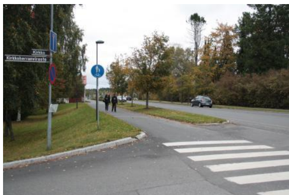
Kuva 24. Liittymien käytettävyyttä on parannettu jättämällä reunakivet pois jalankulku- ja pyöräteiltä (kuva P. Metsäpuro).
