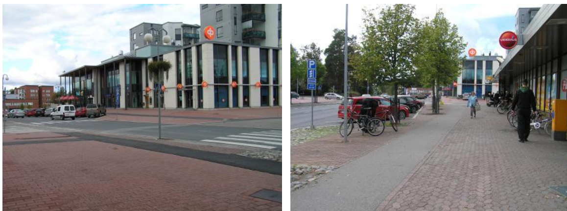
Kuva 30. Pirkkalassa kävely ja pyöräily on erotettu toisistaan ja viihtyisyyttä on lisätty erilaisilla pintamateriaaleilla (kuvat T. Rantala).
