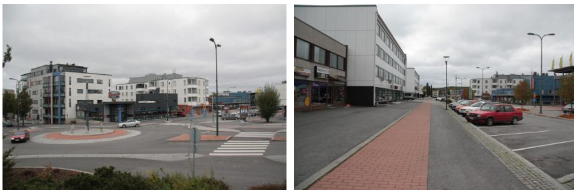
Kuva 29. Nokian keskustassa liikennettä on rauhoitettu ja liikenneympäristöä parannettu esimerkiksi pintamateriaaleilla (kuvat P. Metsäpuro).
