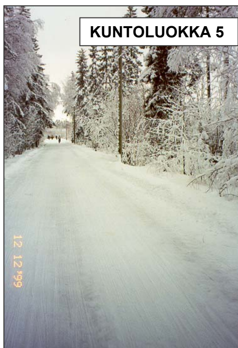
Kuva 15. Erittäin tasainen ja lumesta puhdas väylä. Karhea lumipolanne ei vaadi hiekoitusta. Kuntoluokka 5 = erittäin hyvä. Tutkimusryhmäläisten antamien arvosanojen ka = 4,64 (Oulu, Kuusamontie, 12.12.1999).
