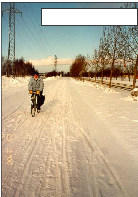
Kuva 18. Epätasaisuus ja lumisuus vaikeuttavat liikennöitävyyttä. Kuntoluokka 2. Tutkimusryhmäläisten antamien arvosanojen ka = 2,08 (Oulu, Limingantulli, 20.2.2000). Lumi ja epätasaisuus saivat 22 mainintaa kuntoluokkaa alentavana tekijänä.
