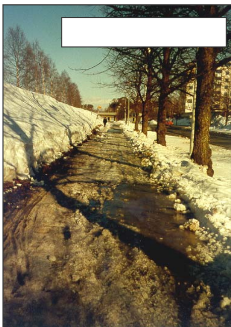
Kuva 17. Väylälle pakkautunut lumi aiheuttaa pyöräilyä häiritsevää epätasaisuutta. Väylän kapeus vaikeuttaa tasaiseksi höyläystä. Kuntoluokka = 3. Tutkimusryhmäläisten antamien arvosanojen ka = 3,32 (Oulu, Keskusta 20.2.2000). Epätasaisuus oli merkittävin kuntoluokkaa alentava tekijä (16/25) ennen lunta (11/25).
