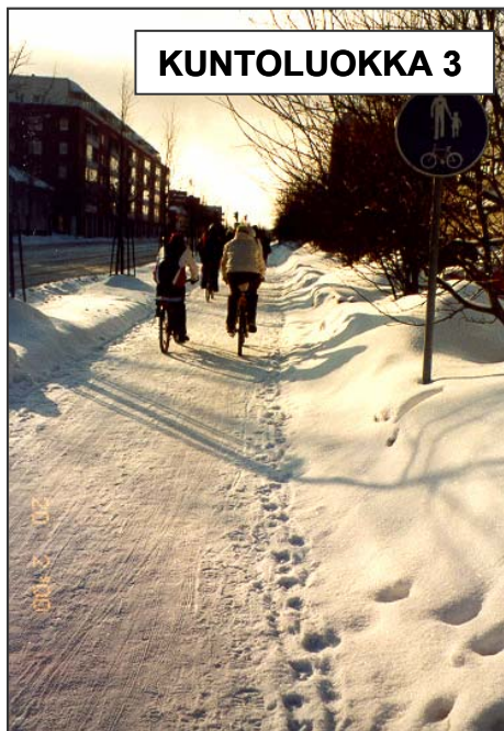
Kuva 17. Väylälle pakkautunut lumi aiheuttaa pyöräilyä häiritsevää epätasaisuutta. Väylän kapeus vaikeuttaa tasaiseksi höyläystä. Kuntoluokka = 3. Tutkimusryhmäläisten antamien arvosanojen ka = 3,32 (Oulu, Keskusta 20.2.2000). Epätasaisuus oli merkittävin kuntoluokkaa alentava tekijä (16/25) ennen lunta (11/25).
