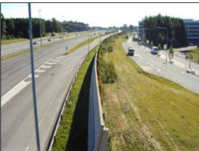
Kuva 1-10: Lahdenväylä ja Viikinportinkatu Maaherrantien sillalta kuvattuna
