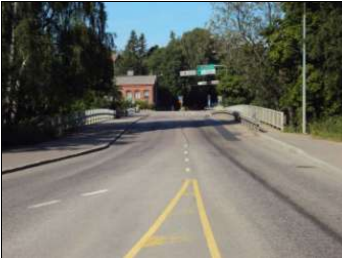
Kuva 1-11: Näkymä Viikintien silloille idästä
