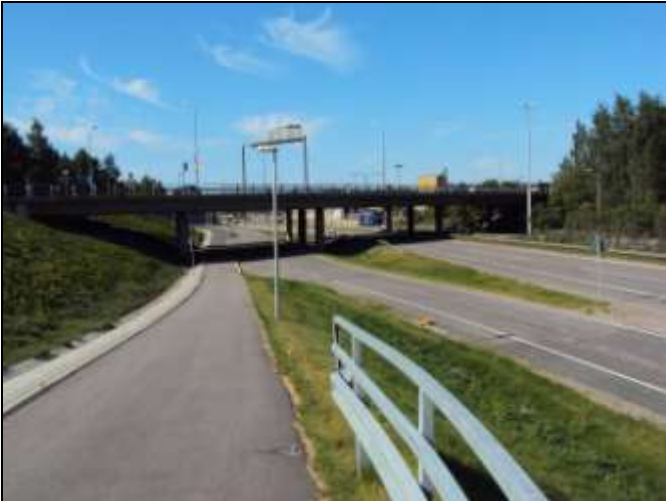
Kuva 2-5: Koskelantien Lahdenväylän ylittävä silta pohjoisesta
