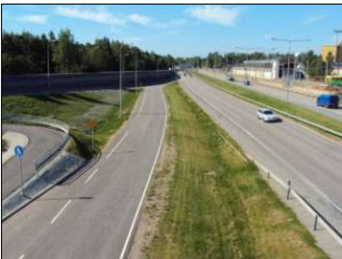
Kuva 1-6: Kustaa Vaasan tie Koskelantien sillalta kuvattuna
